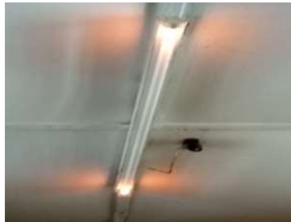
(d) Bad ballast/starter fluorescent
